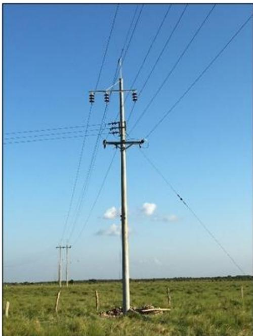
**Ilustración 36.** Reposición poste de concreto línea 34.5 KV
